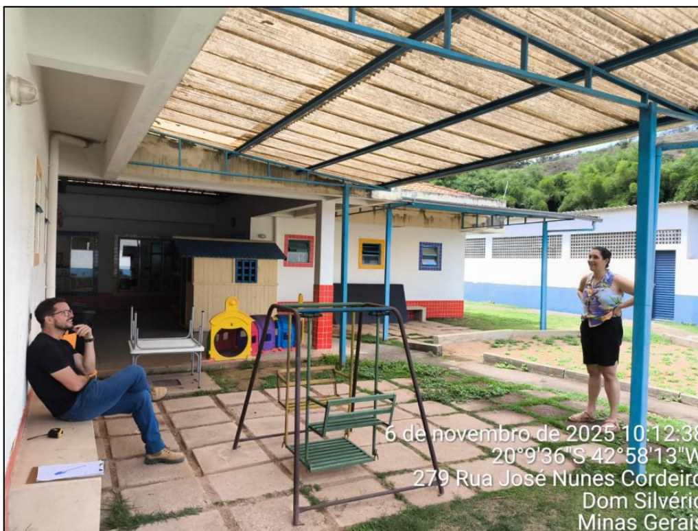
Foto 01- Local onde será construída a nova sala
