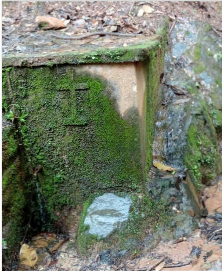
Foto 09- Estrutura existente a ser lixada para remoção de lodo e posteriormente pintada
