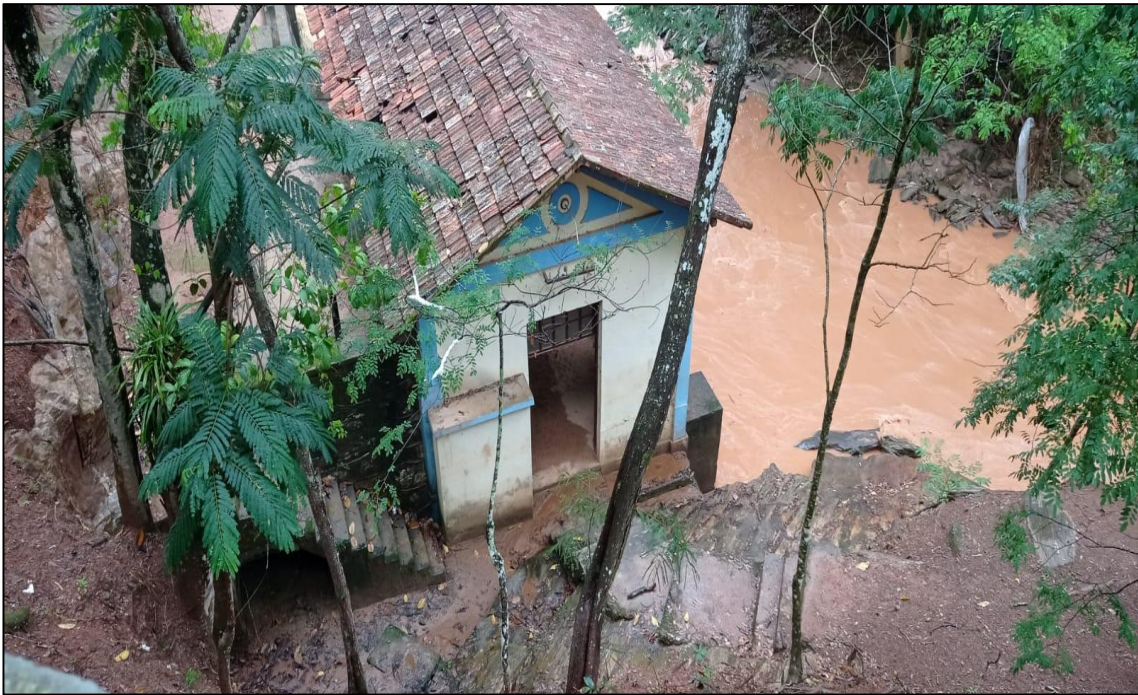
Foto 01- Vista da antiga usina hidroelétrica
