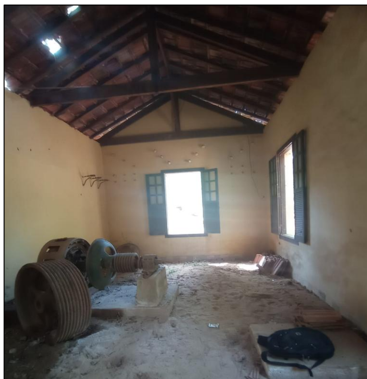
Foto 06- Vista interna da antiga usina hidroelétrica
