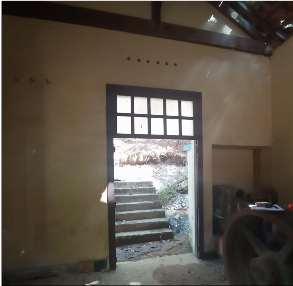
Foto 07- Vista interna da antiga usina hidroelétrica
