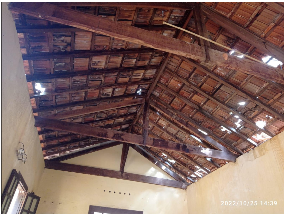
Foto 05- Engradamento a ser lixado e pintado com verniz
