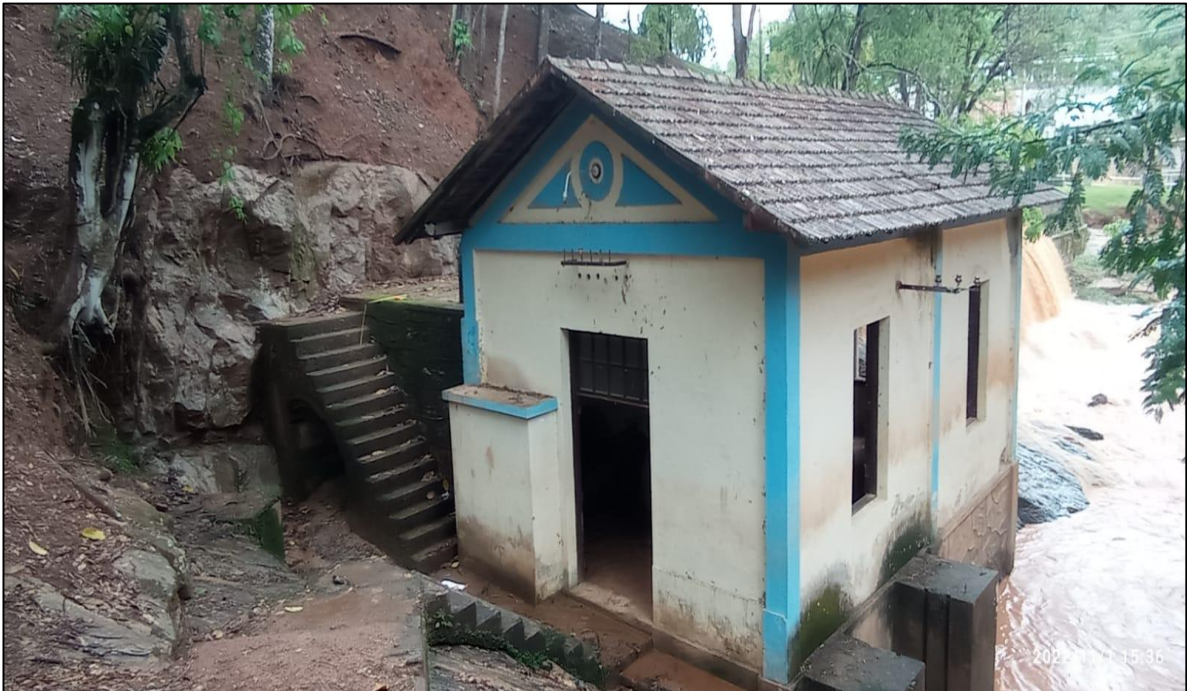
Foto 03- Vista da antiga usina hidroelétrica
