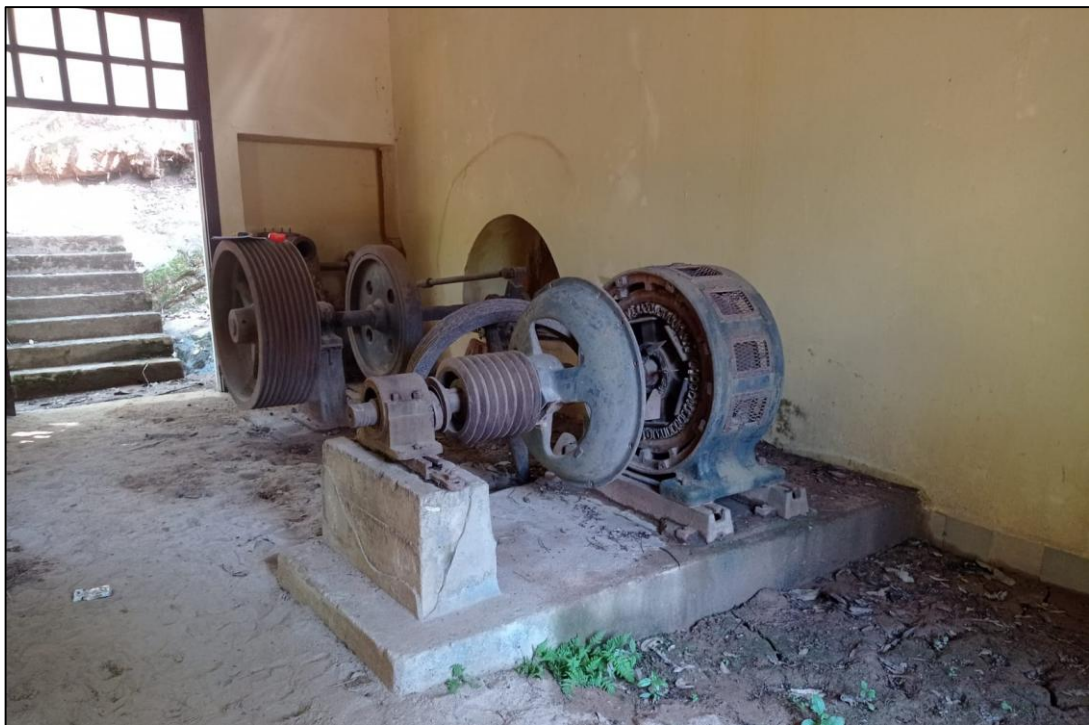
Foto 08- Bases existentes a serem pintadas
