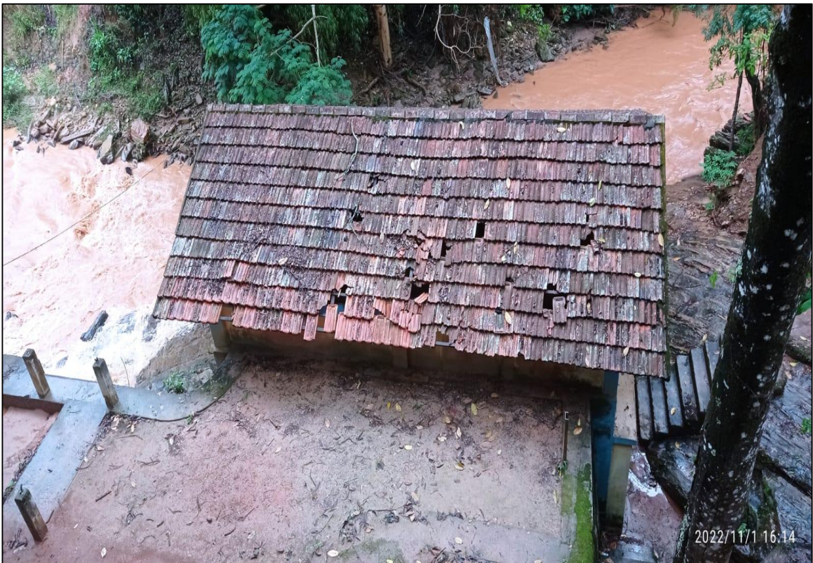
Foto 04- Vista superior do telhado da antiga usina hidroelétrica
