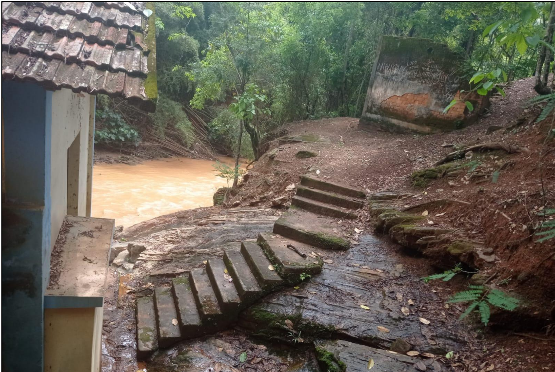
Foto 11- Vista da escada de acesso ao anexo
