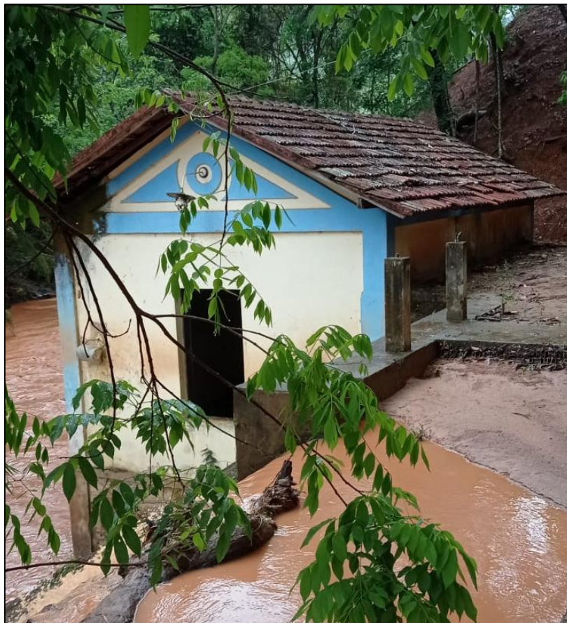
Foto 02- Vista da antiga usina hidroelétrica
