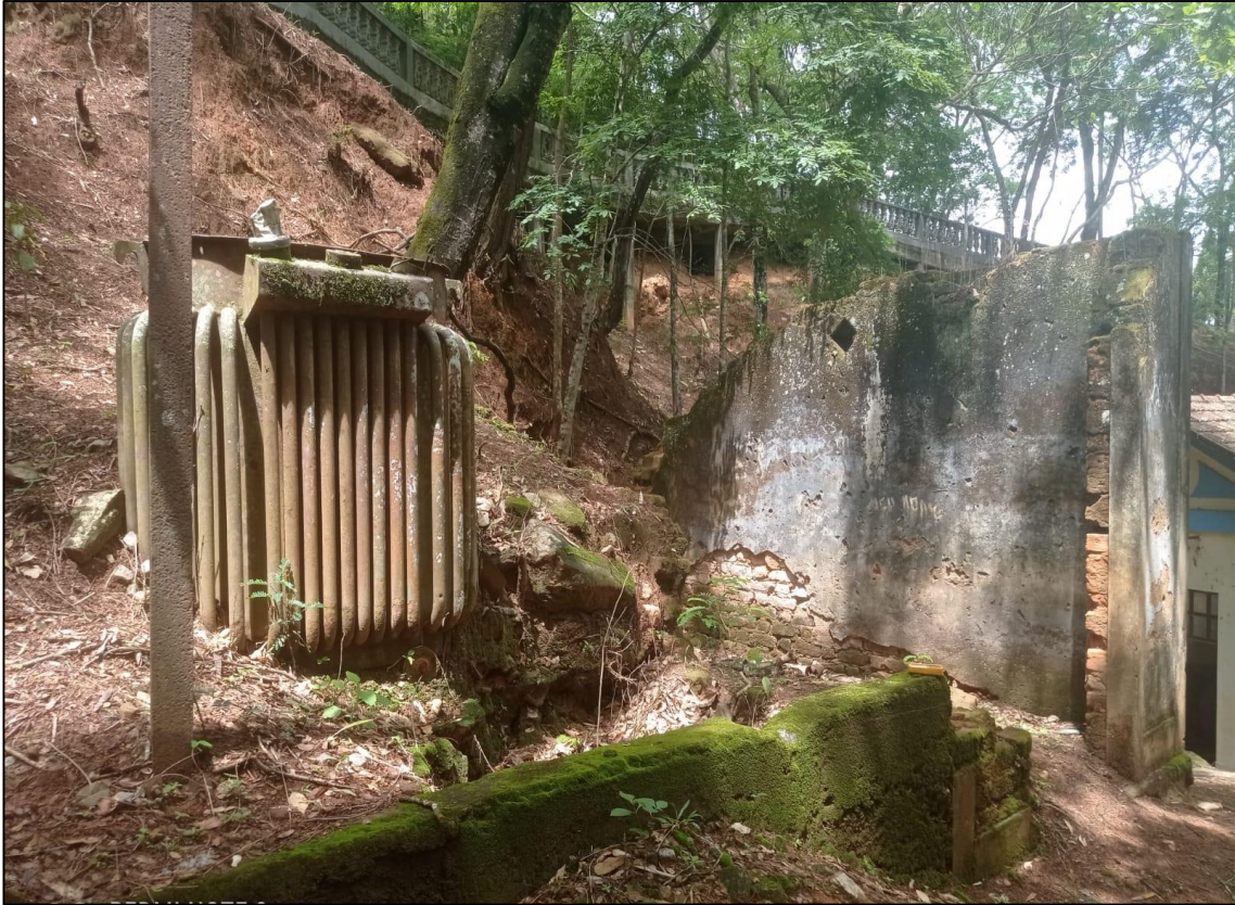
Foto 13- Paredes existentes do anexo a serem demolidas
