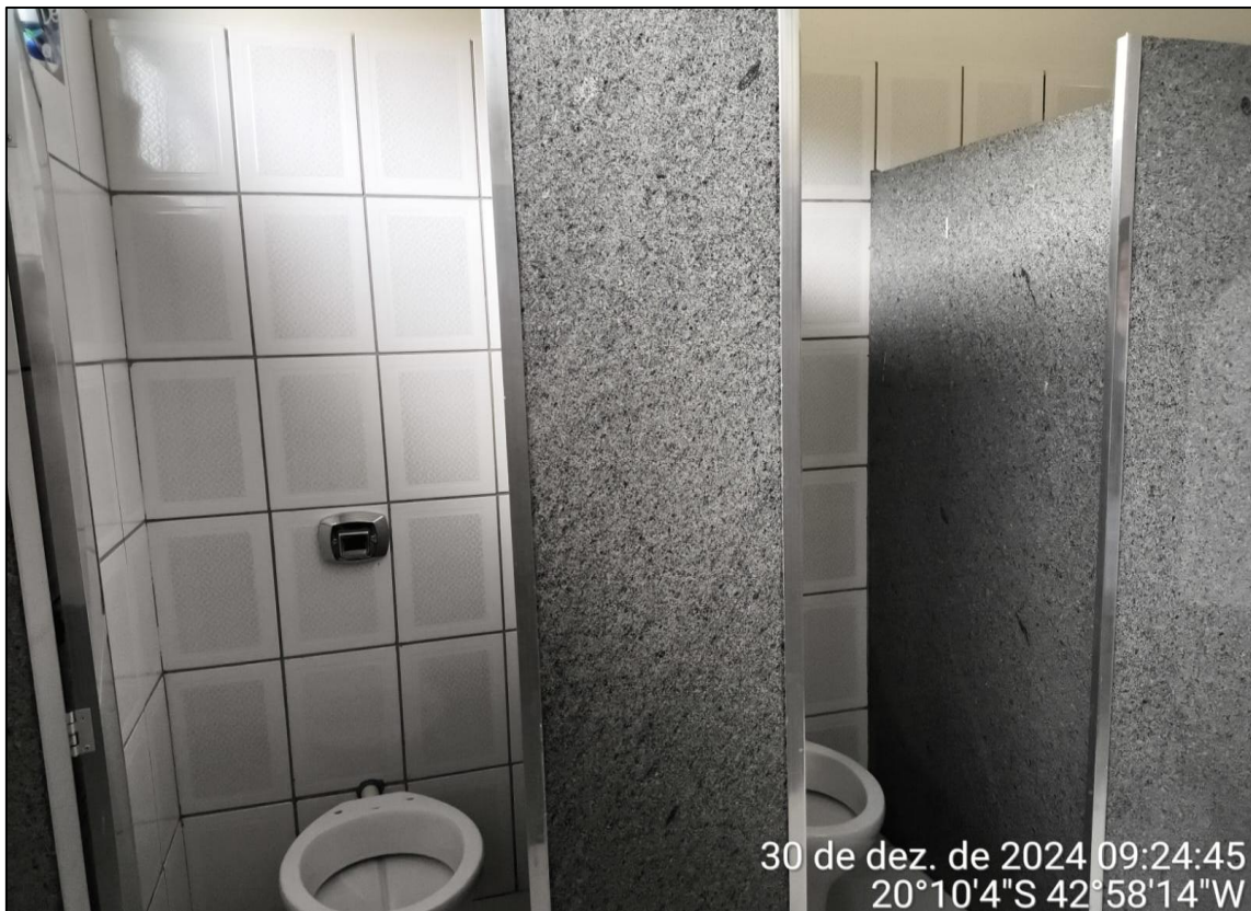
Foto 06- Vista interna do banheiro
