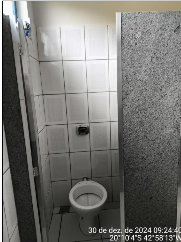
Foto 07- Vista interna do banheiro
