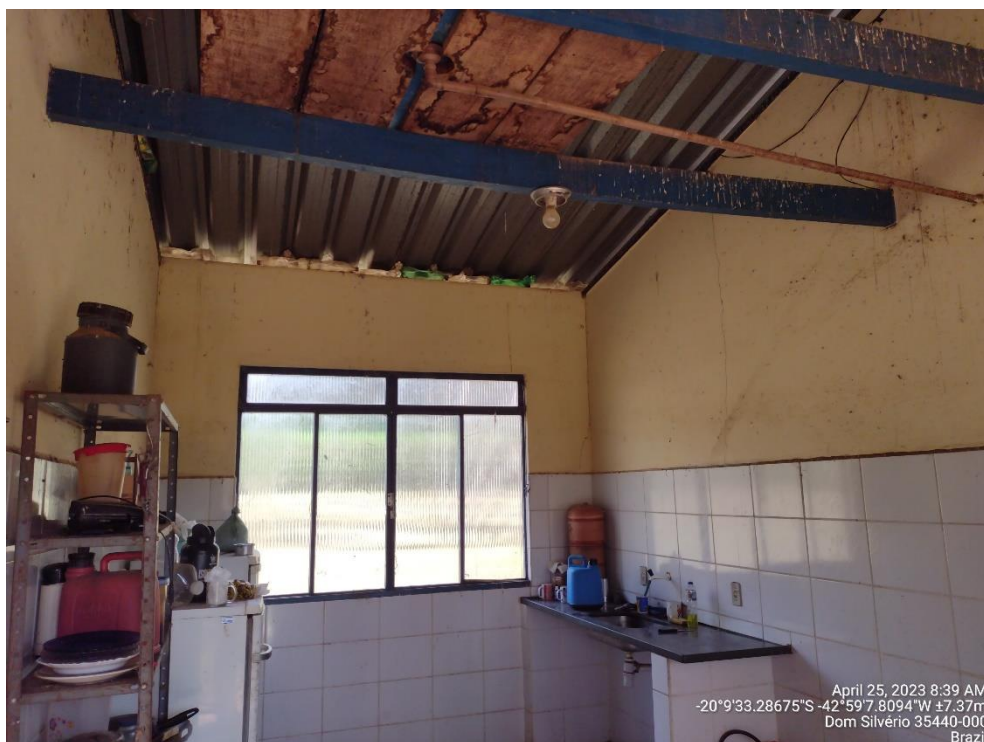
Figura 11. Vista da cozinha, no prédio da administração.
