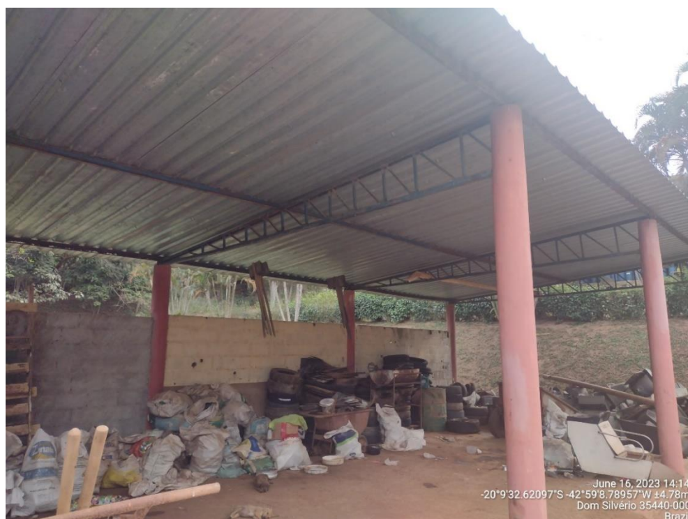
Figura 14. Vista do galpão 02.
