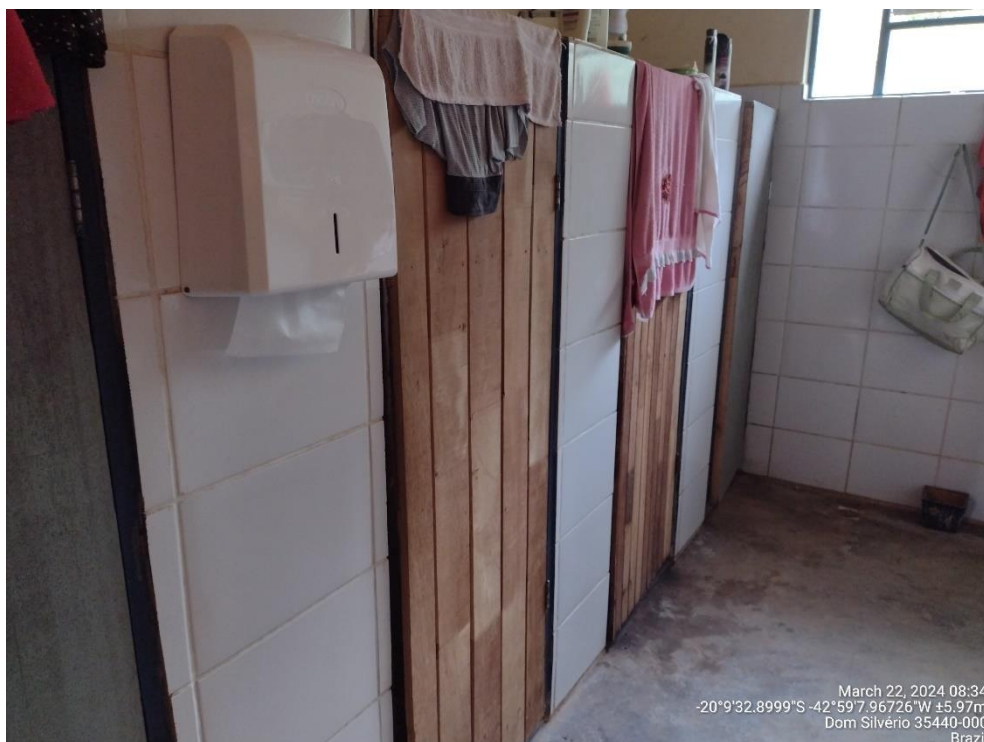
Figura 19. Vista do interior de um dos banheiros, situado no prédio da administração.
