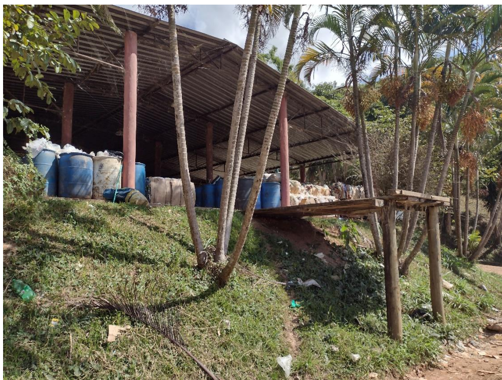
Figura 3. Vista da fachada principal do galpão de triagem.
