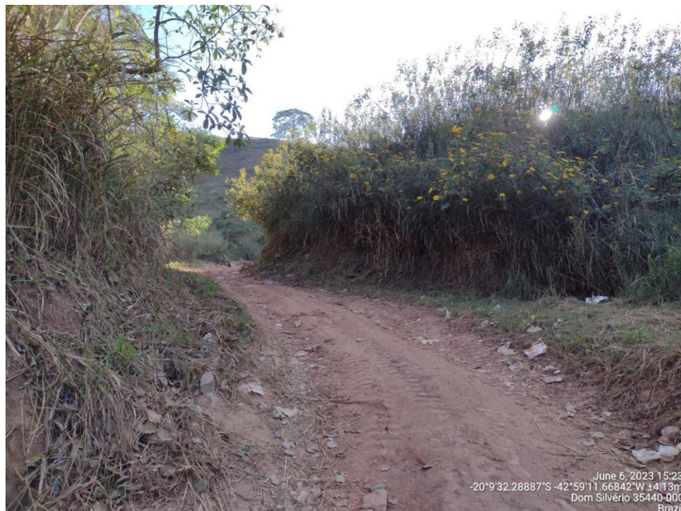
Figura 13. Vias no interior da Usina sem canaleta/sarjeta.
