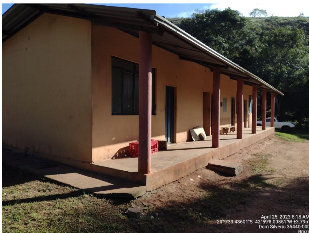
Figura 8. Vista da fachada principal e da lateral do prédio da administração.
