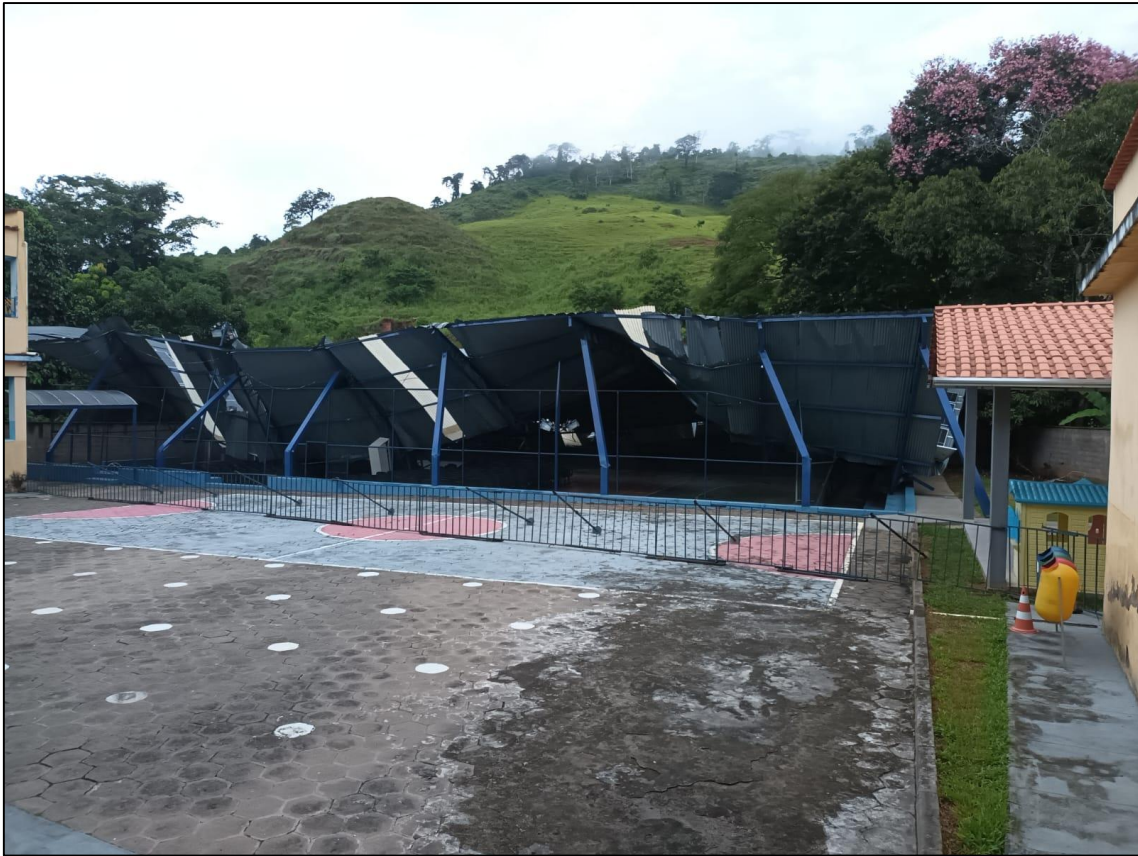
Foto 13 – Quadra da escola a ser reconstruída
