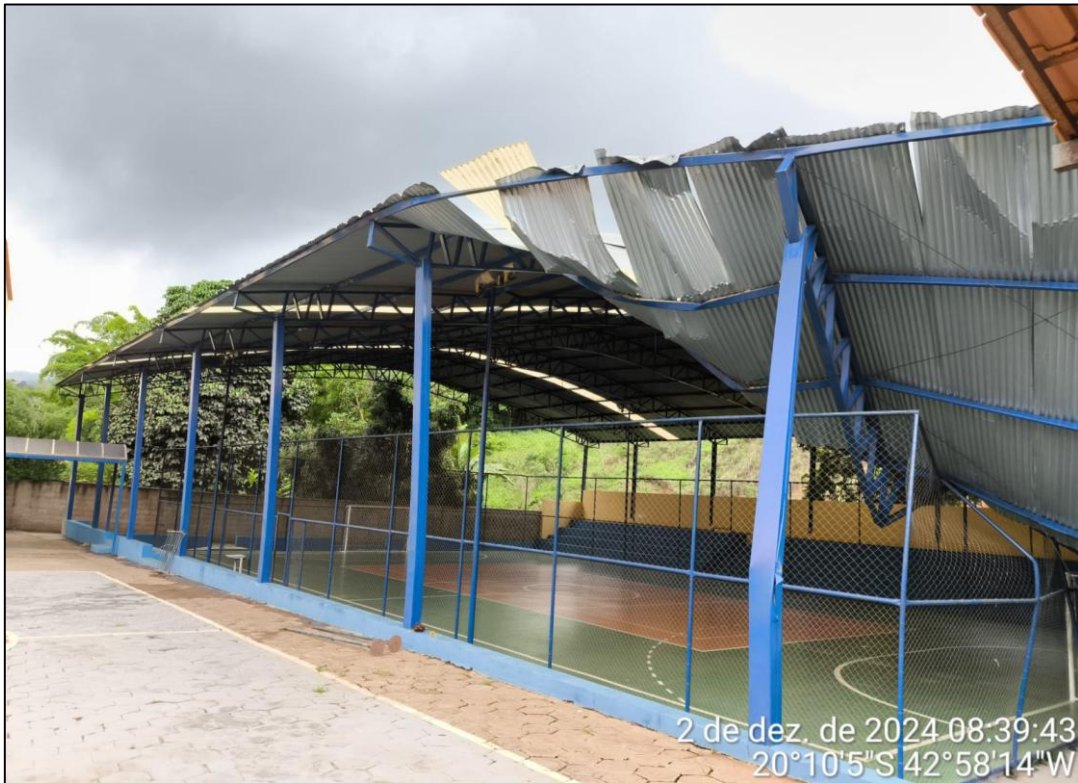
Foto 01 – Quadra da escola a ser reconstruída
