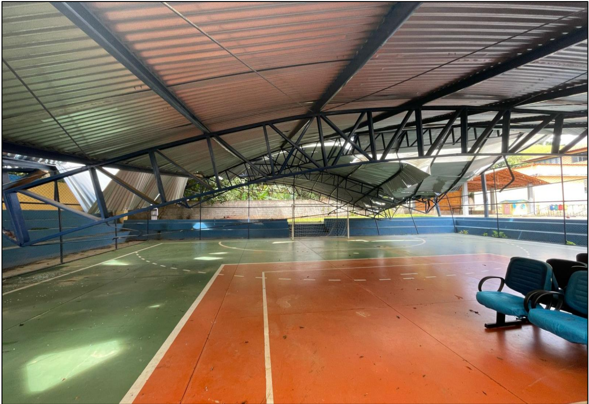
Foto 09 – Quadra da escola a ser reconstruída
