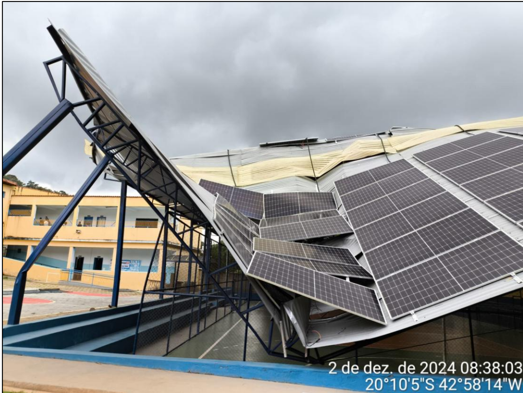
Foto 05 – Quadra da escola a ser reconstruída
