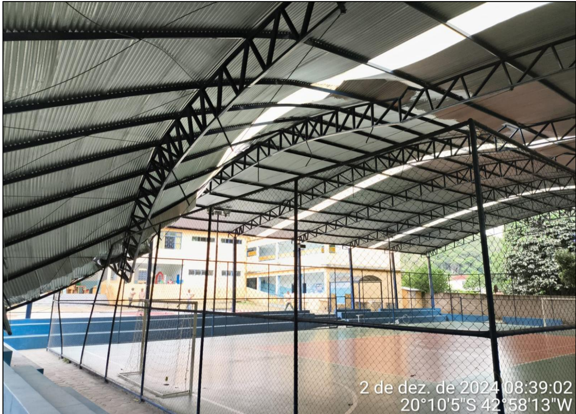
Foto 03 – Quadra da escola a ser reconstruída
