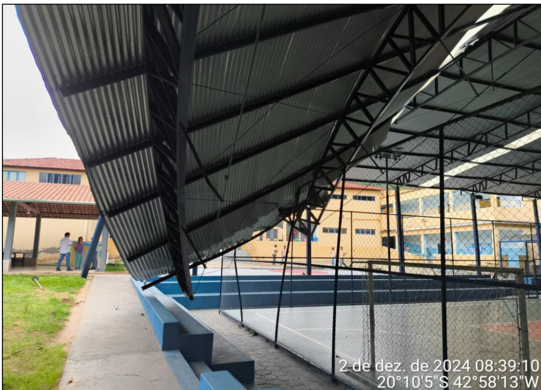
Foto 02 – Quadra da escola a ser reconstruída
