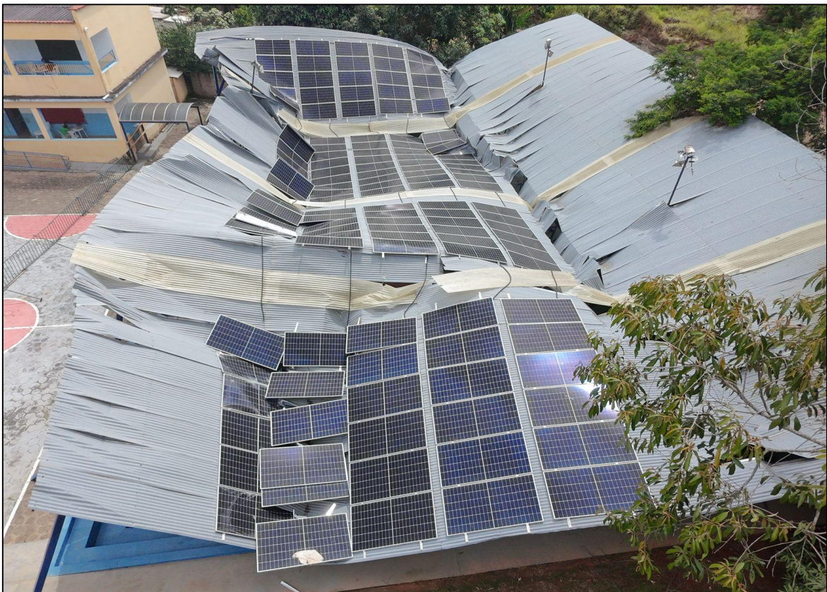
Foto 10 – Quadra da escola a ser reconstruída
