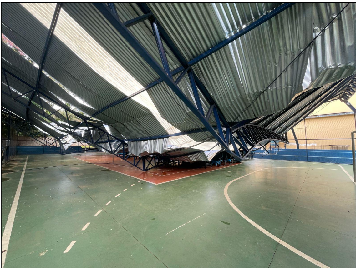
Foto 12 – Quadra da escola a ser reconstruída
