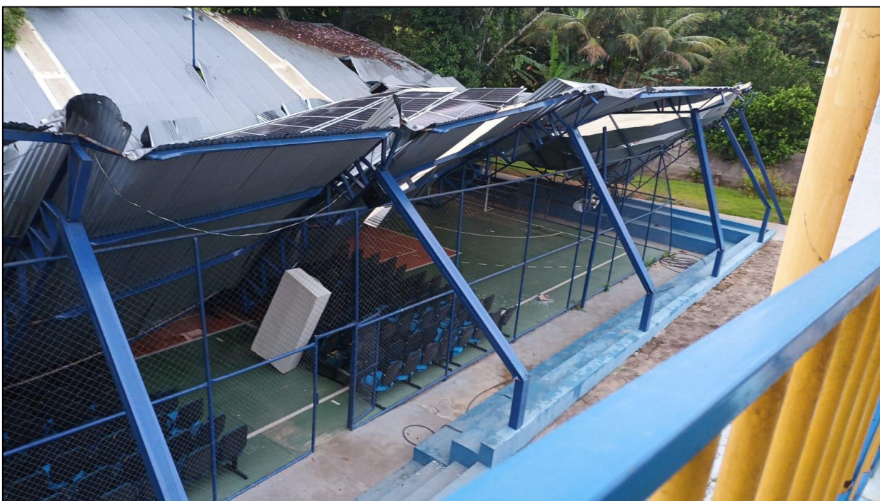
Foto 08 – Quadra da escola a ser reconstruída
