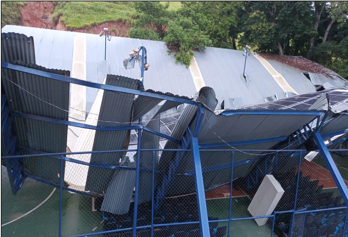
Foto 11 – Quadra da escola a ser reconstruída
