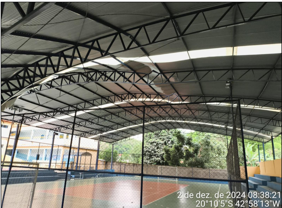
Foto 04 – Quadra da escola a ser reconstruída
