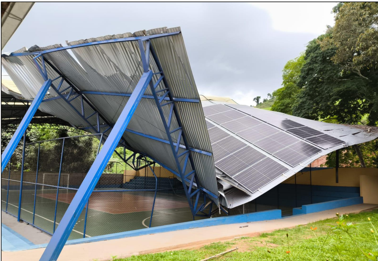
Foto 07 – Quadra da escola a ser reconstruída
