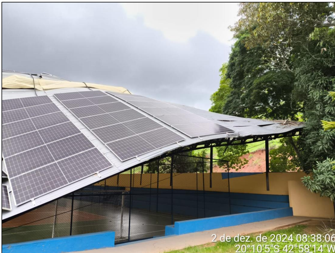
Foto 06 – Quadra da escola a ser reconstruída
