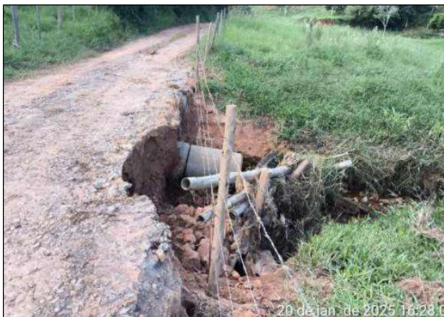
Foto 05 - Meta 22: Local onde será executado o BSTC Ø 1,00m – estrada do Matipó – próximo a Marcelo Guimarães 02
