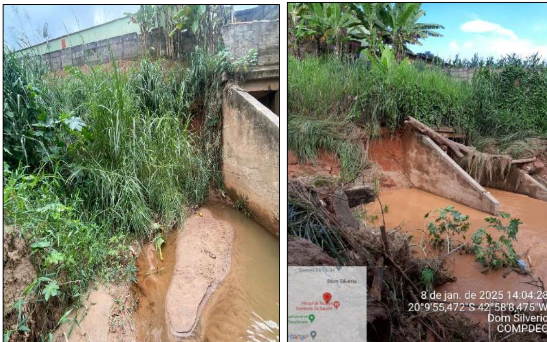
Foto 01 - Meta 01: Local onde será executado o muro de contenção
