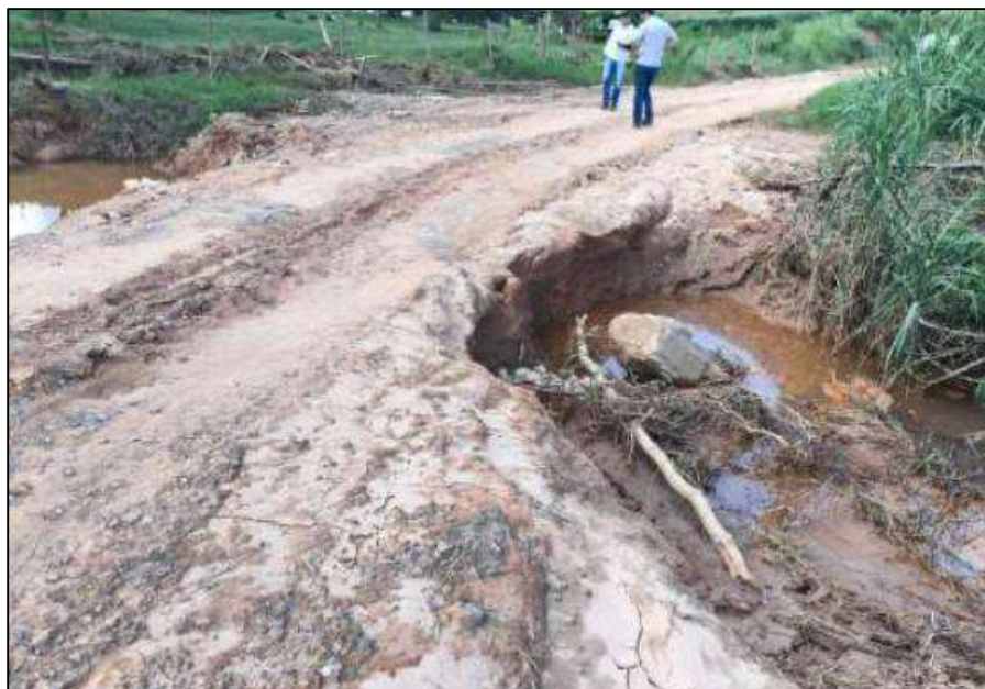
Foto 02 - Meta 03: Local onde será executado o BSTC Ø 1,00m – próximo a Fazenda Santa Bárbara
