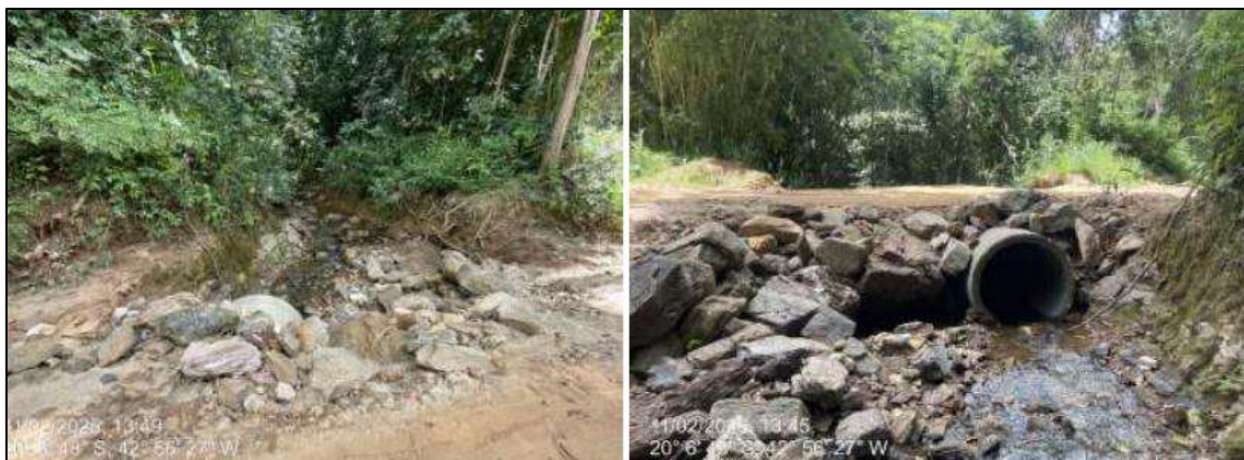
Foto 05 - Meta 24: Local onde será executado o BSTC Ø 1,20m – estrada da Biquinha – próximo a Paulo/Ivete
