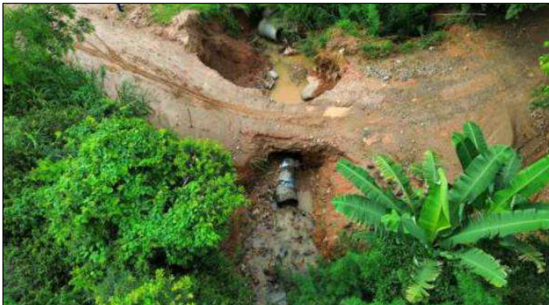
Foto 01 - Meta 04: Local onde será executado o bueiro armco Ø 2,00m – estrada do Funil – próximo a Gorete
