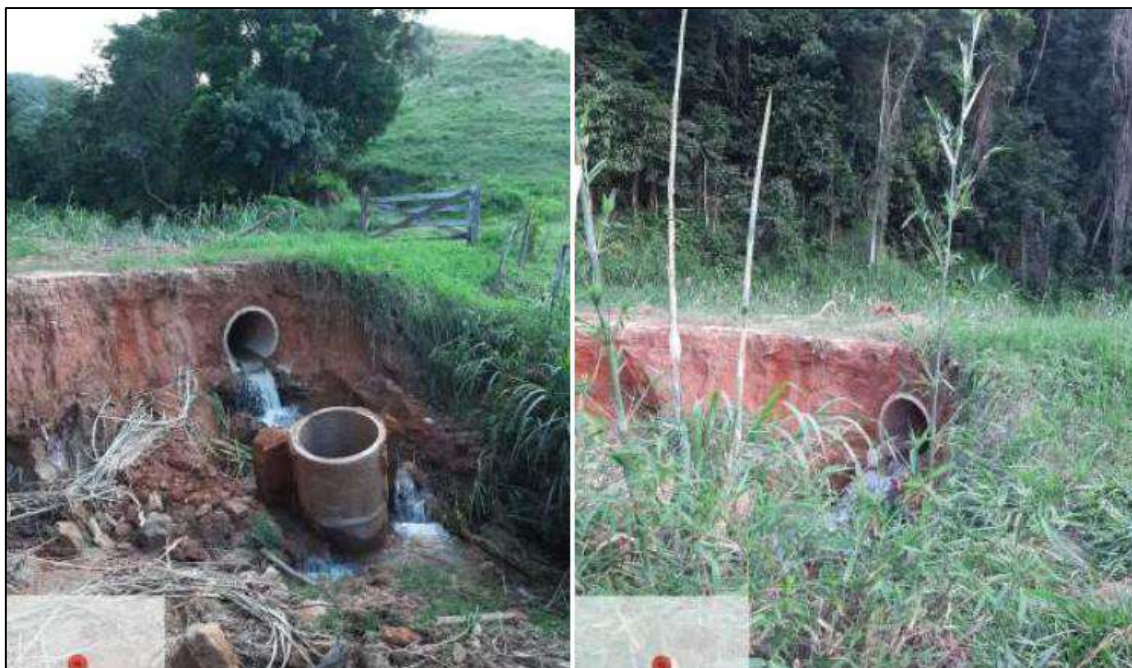
Foto 03 - Meta 20: Local onde será executado o bueiro Armco Ø 2,80m – Derrubada
