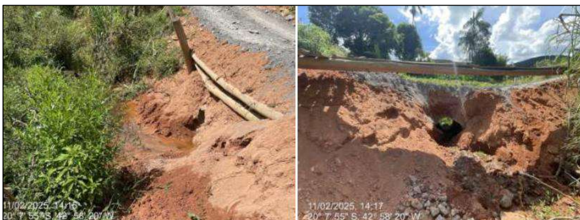
Foto 04 - Meta 23: Local onde será executado o BSTC Ø 1,00m – estrada da Campanha – próximo a Toledo
