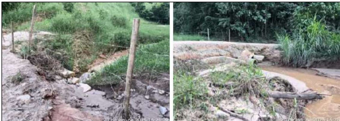
Foto 01 - Meta 07: Local onde será executado o BSTC Ø 1,00m – estrada do Quintão - próximo a propriedade de Zezinho
