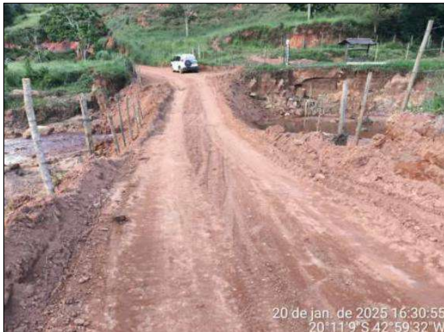
Foto 01 - Meta 02: Local onde será executado o bueiro Armco Ø 2,00m – próximo a propriedade de Marcelo Guimarães 01
