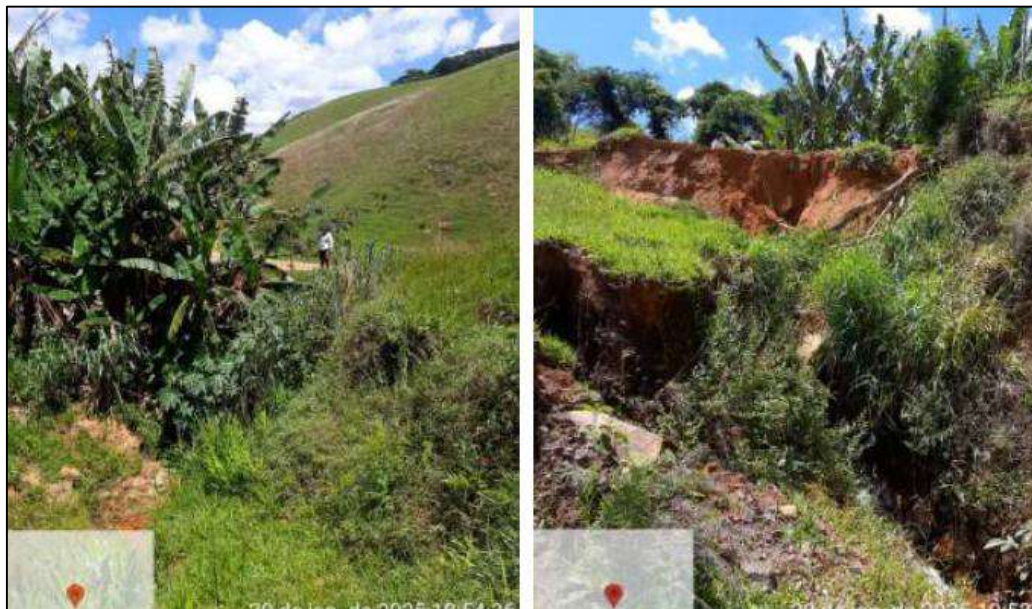
Foto 01 - Meta 10: Local onde será executado o BSTC Ø 1,20m – estrada da Biquinha – próximo a Deca 01
