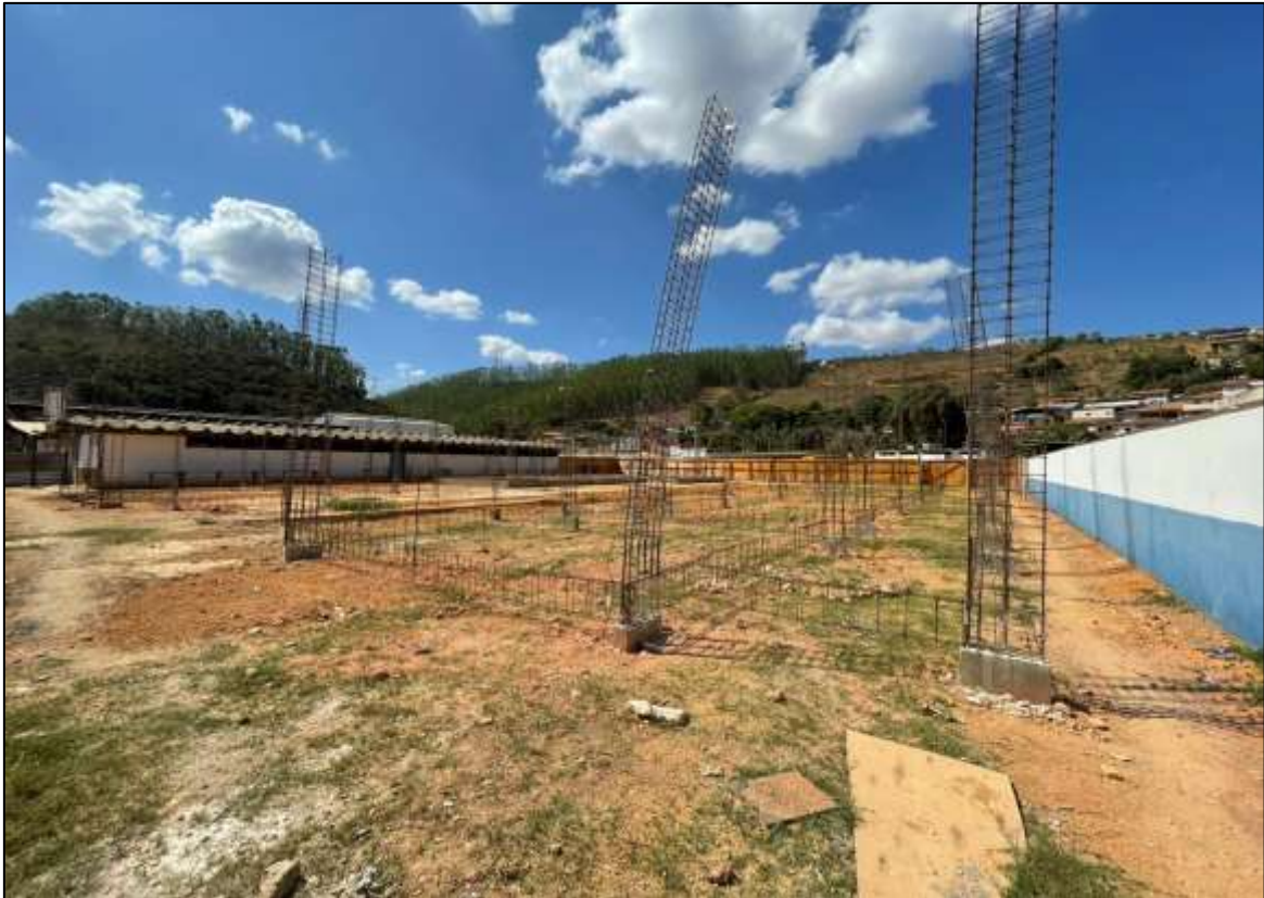
Foto 07 - Corte, dobra e armação de vigamento baldrame e pilares
