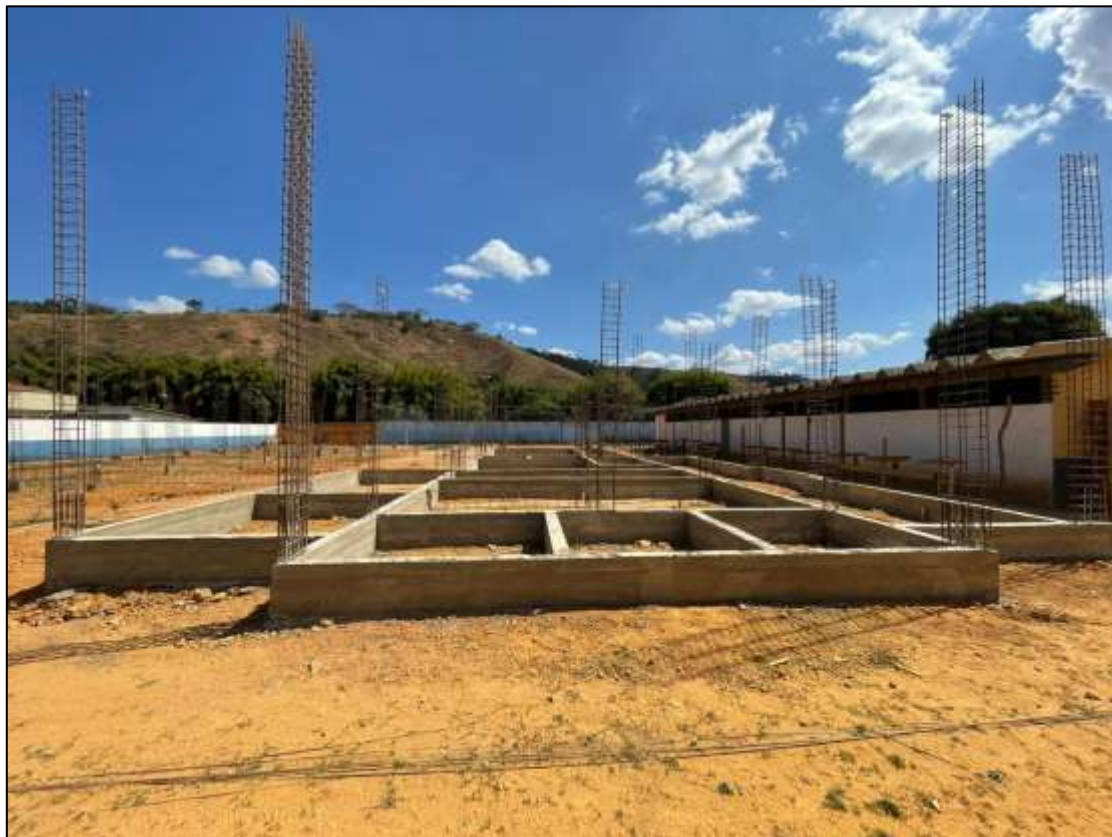
Foto 04- Vigamento baldrame – parcialmente executado
