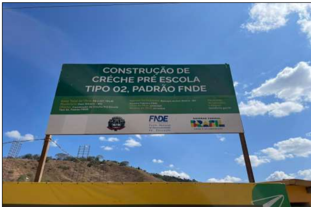
Foto 02- Instalação de placa – já executado
