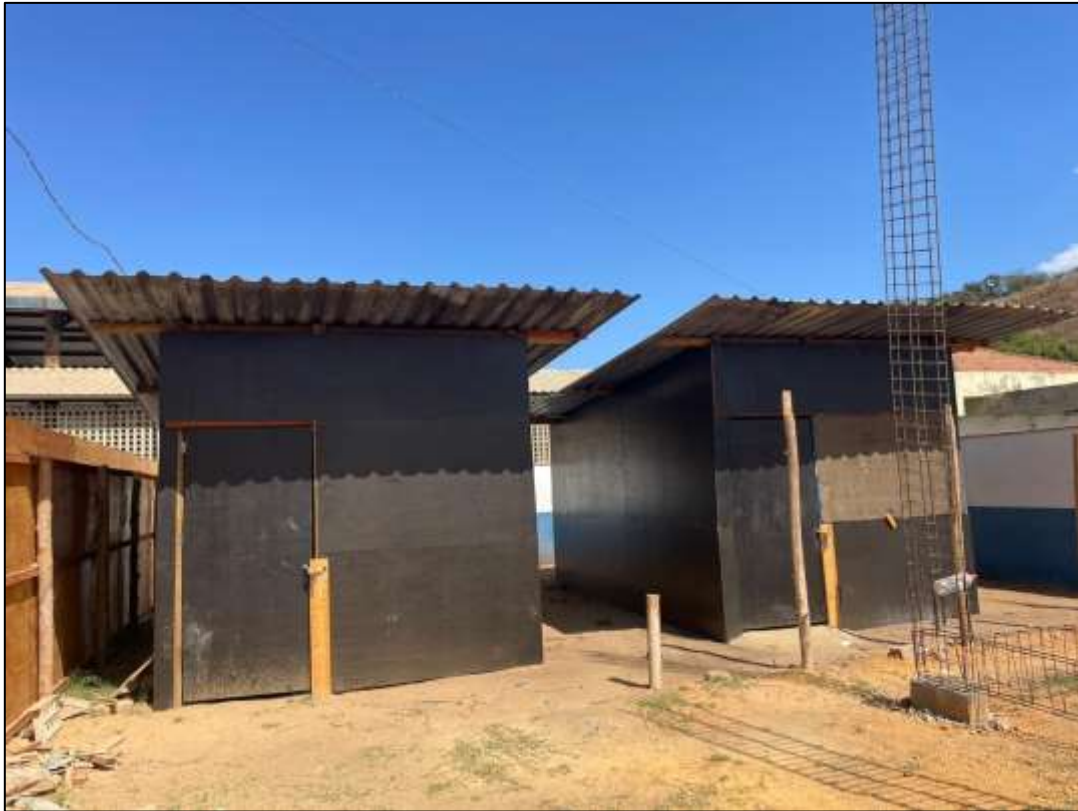
Foto 03- Barracão de obra – já executado
