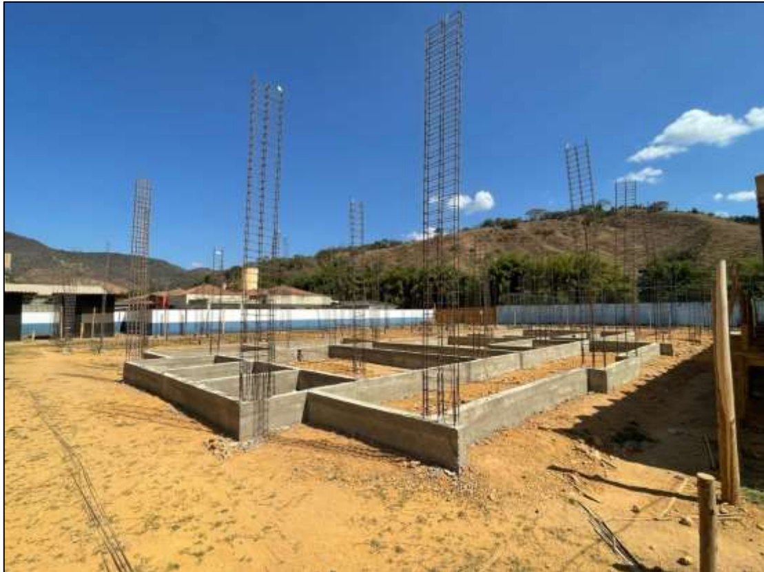
Foto 05- Vigamento baldrame – parcialmente executado
