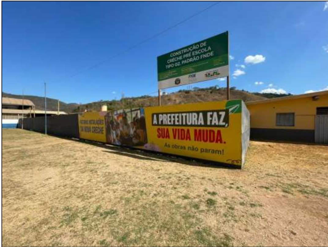
Foto 01- Tapume para fechamento da obra já executado
