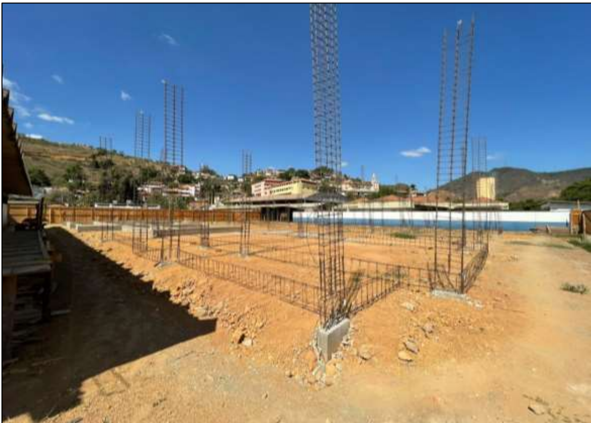
Foto 08 - Corte, dobra e armação de vigamento baldrame e pilares
