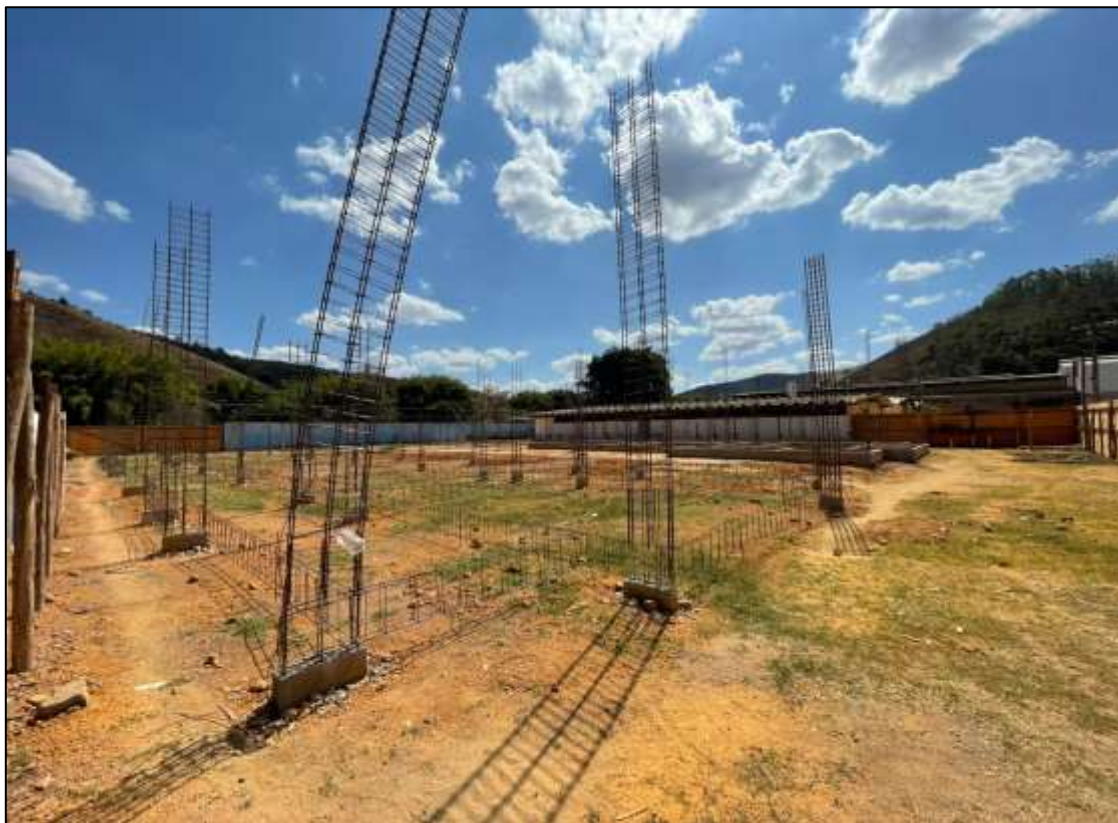
Foto 06- Corte, dobra e armação de vigamento baldrame e pilares
