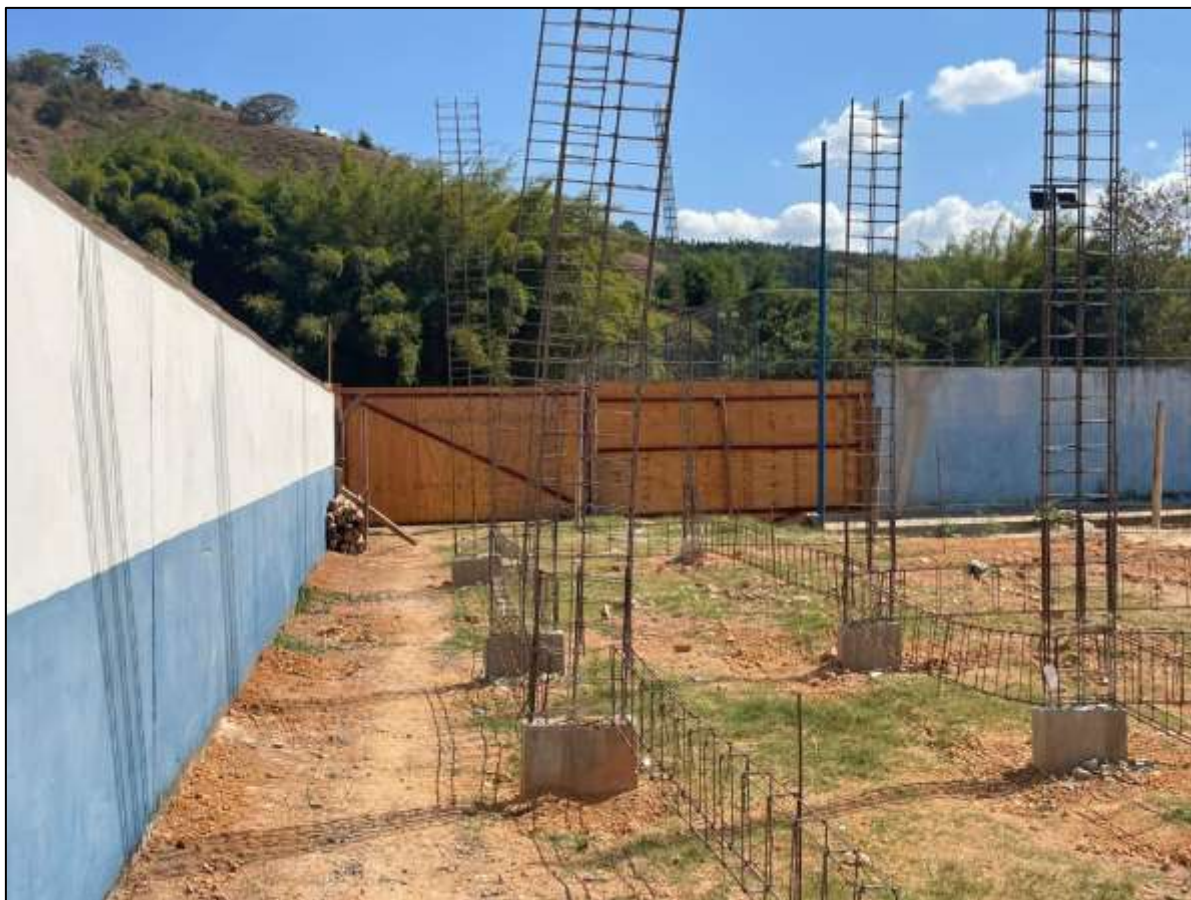
Foto 09- Corte, dobra e armação de vigamento baldrame e pilares
