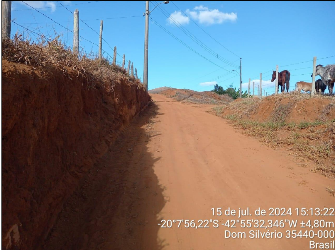
Foto 04- Rua de acesso ao Campo que irá receber pavimentação em bloquete
