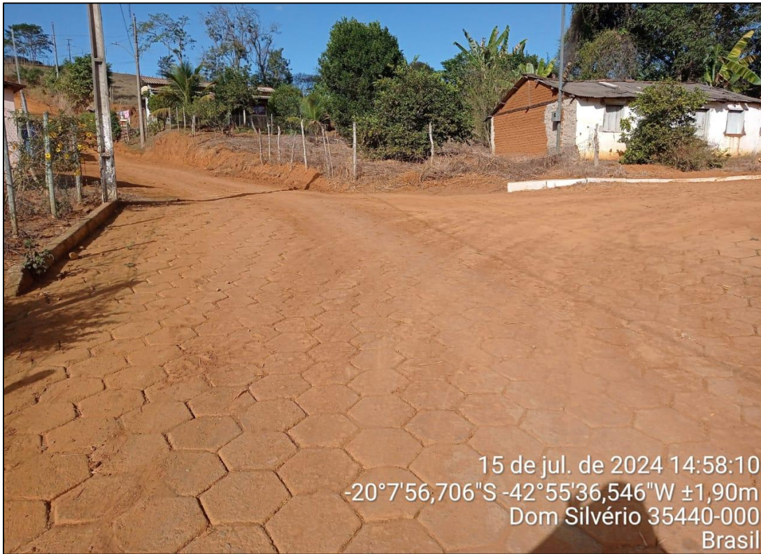
Foto 01- Rua de acesso ao Campo que irá receber pavimentação em bloquete
