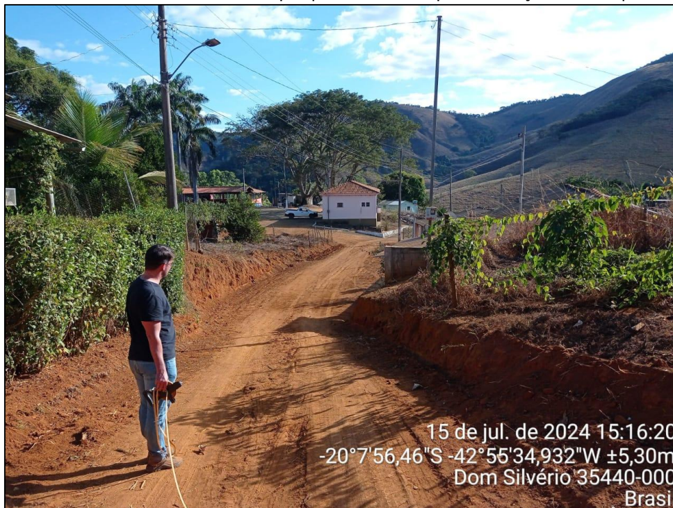
Foto 08- Rua de acesso ao Campo que irá receber pavimentação em bloquete
