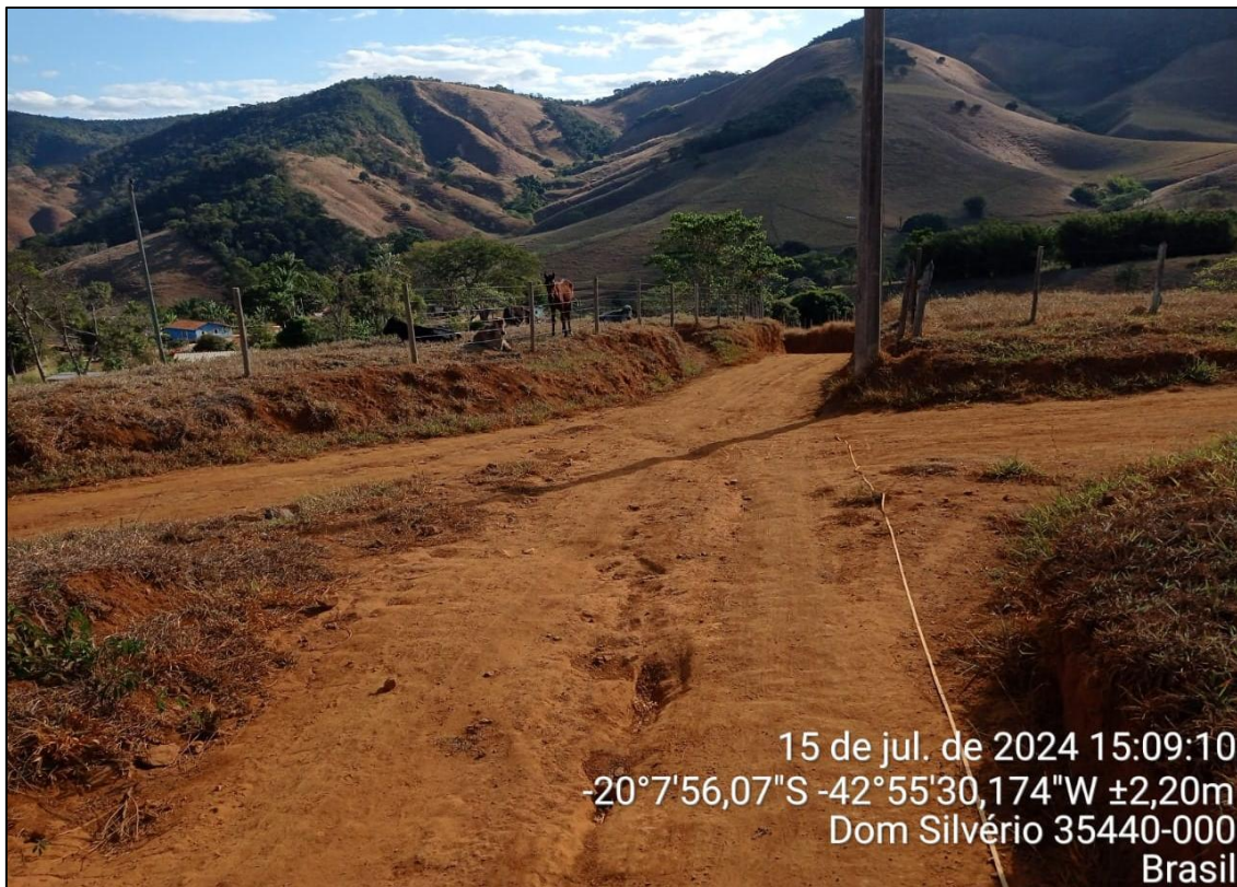
Foto 06- Rua de acesso ao Campo que irá receber pavimentação em bloquete
