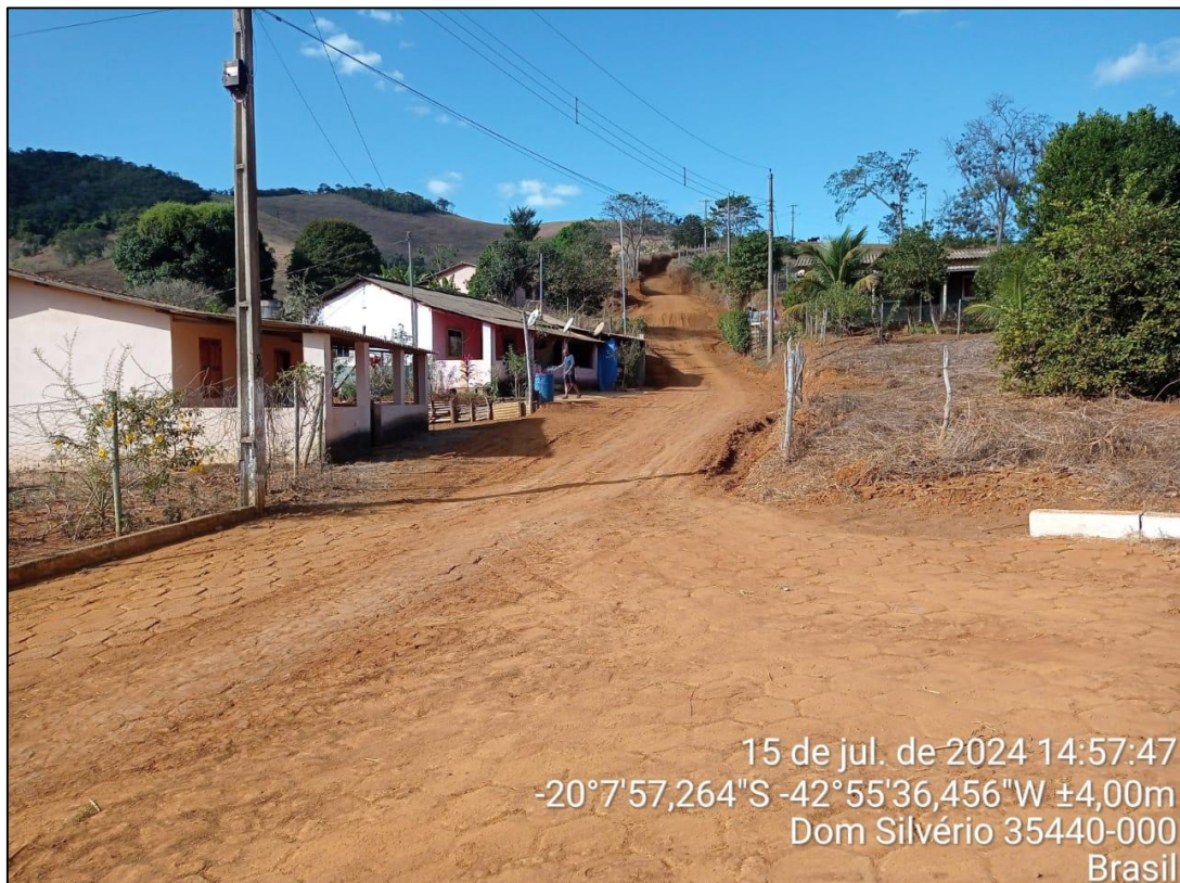
Foto 02- Rua de acesso ao Campo que irá receber pavimentação em bloquete
