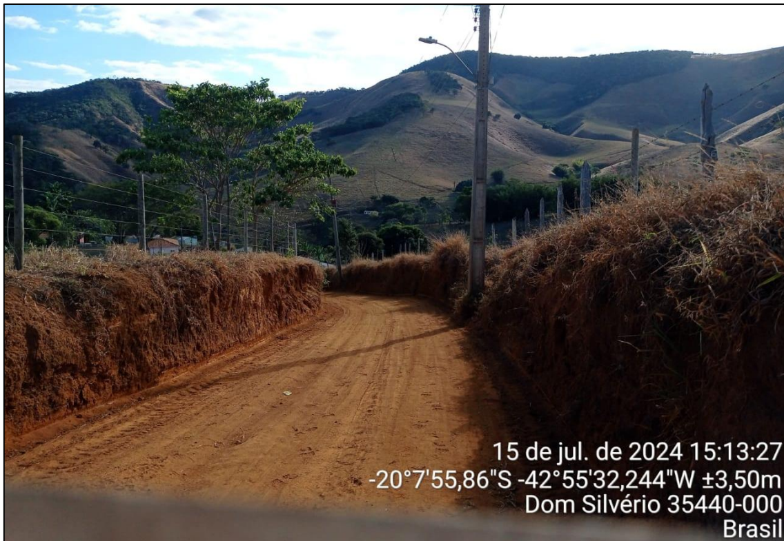
Foto 03- Rua de acesso ao Campo que irá receber pavimentação em bloquete
