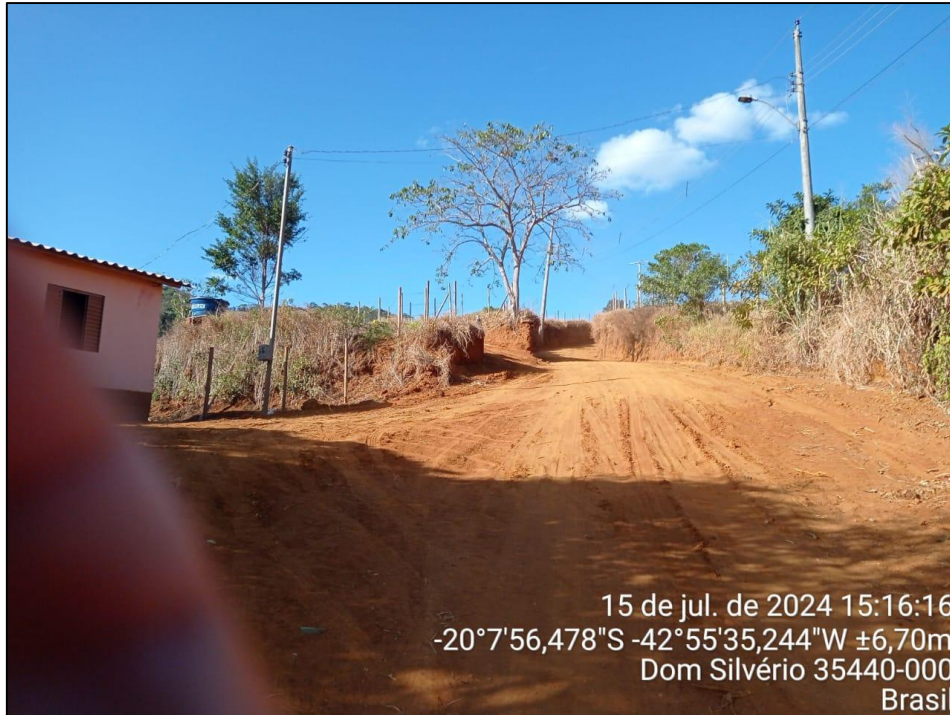
Foto 07- Rua de acesso ao Campo que irá receber pavimentação em bloquete
