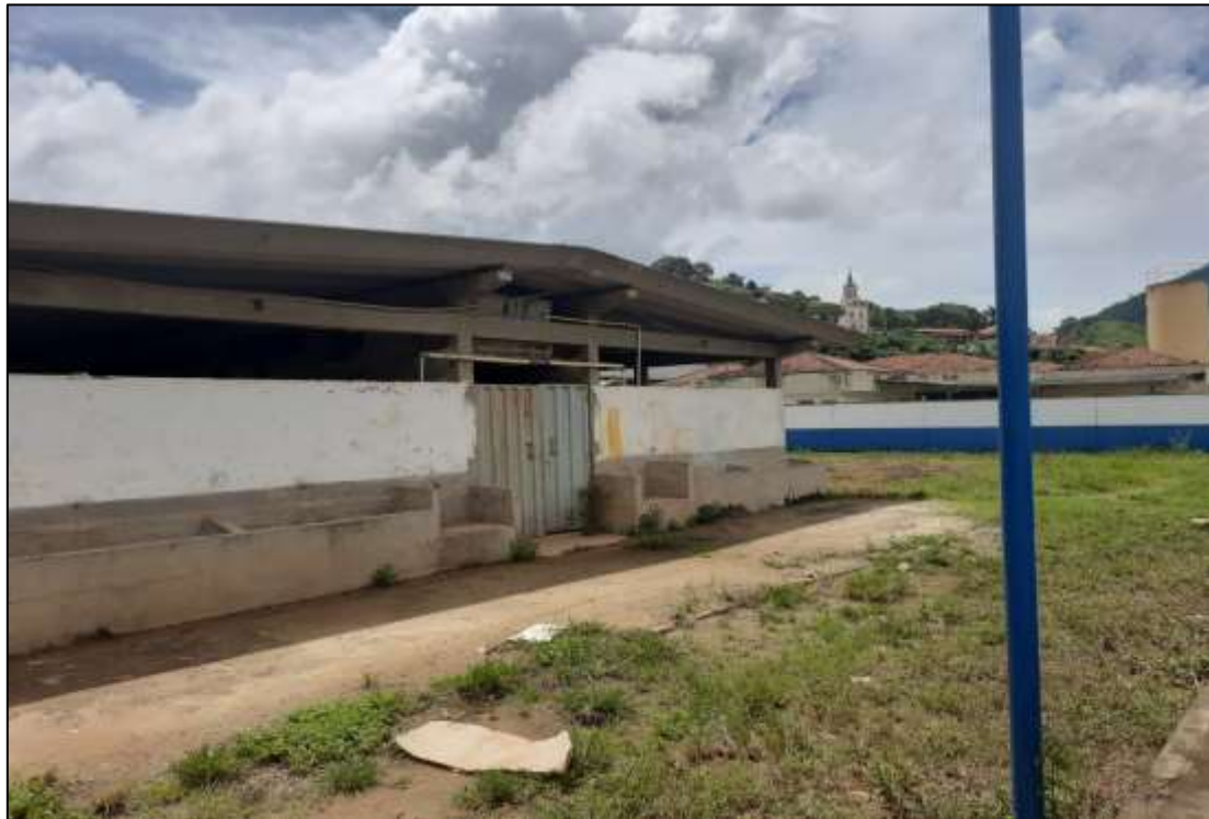
Foto 02- Local onde será implantada a Creche ( O galpão será demolido pela prefeitura)
