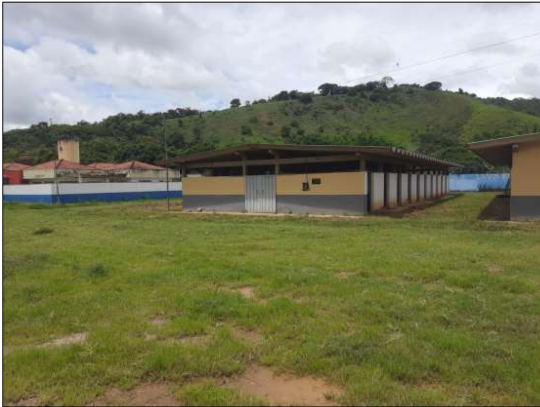
Foto 01- Local onde será implantada a Creche ( O galpão será demolido pela prefeitura)
