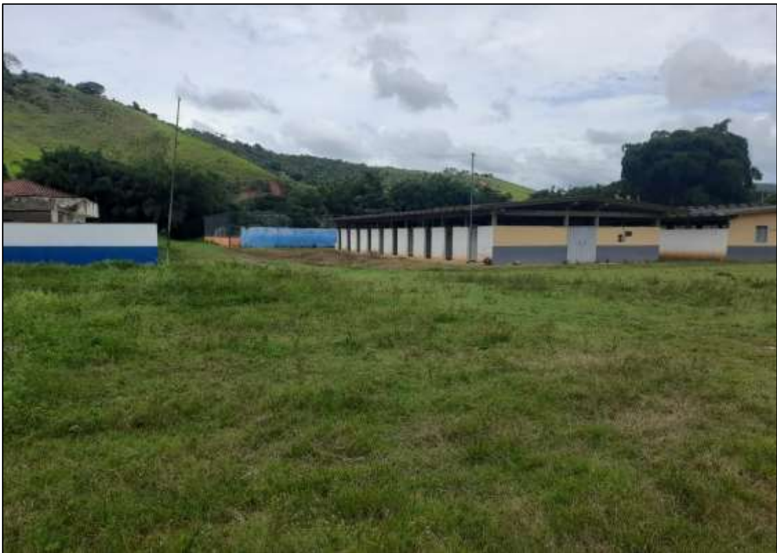
Foto 04- Local onde será implantada a Creche ( O galpão será demolido pela prefeitura)
