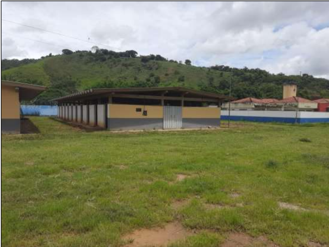
Foto 05- Local onde será implantada a Creche (O galpão será demolido pela prefeitura)
