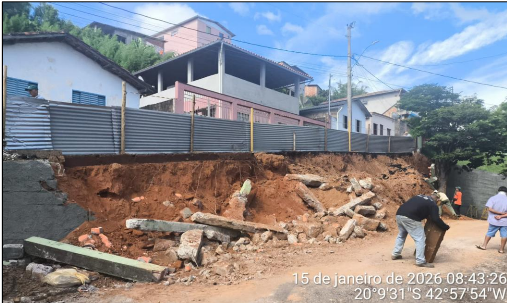
Foto 01- Local onde será construído o novo muro
