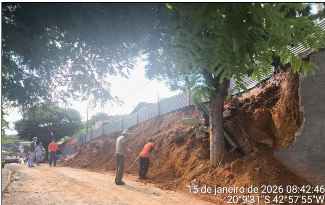
Foto 02- Local onde será construído o novo muro
