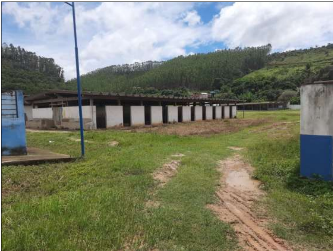
Foto 06- Local onde será implantada a Creche (O galpão será demolido pela prefeitura)
