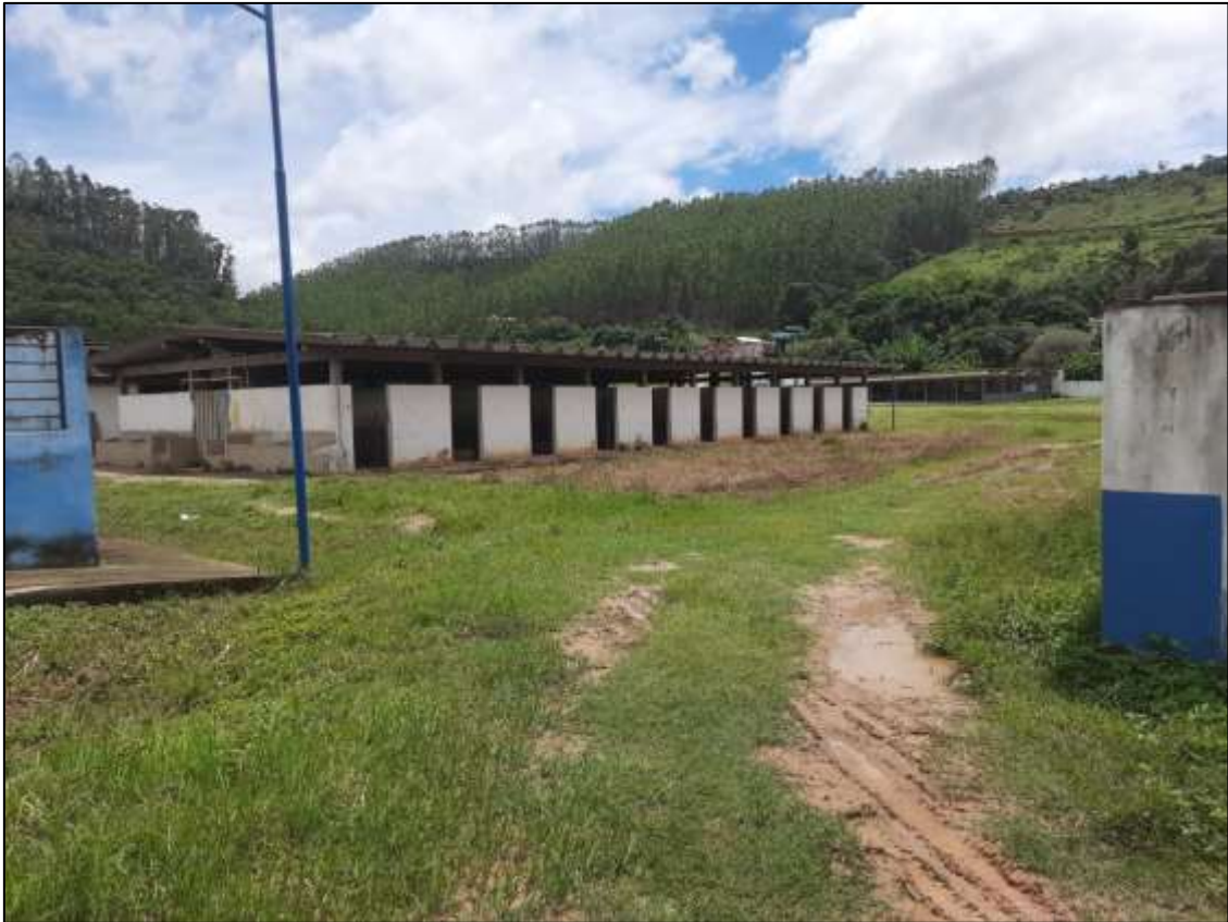
Foto 03- Local onde será implantada a Creche ( O galpão será demolido pela prefeitura)
