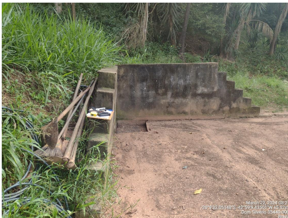
Figura 18. Muro de canto no pátio de degradação.
