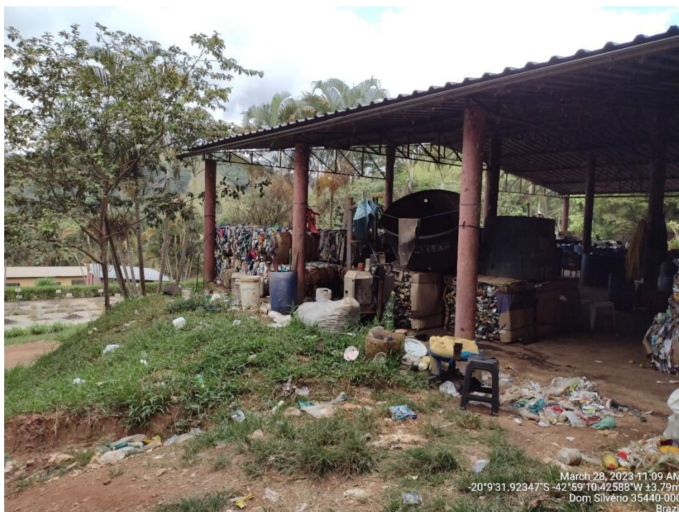
Figura 5. Vista da lateral do galpão de triagem, por onde é feito o acesso a ele.
