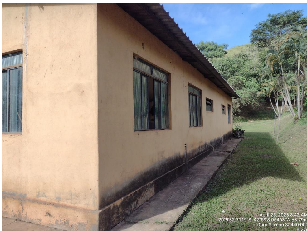
Figura 9. Vista da fachada posterior e da lateral do prédio da administração.
