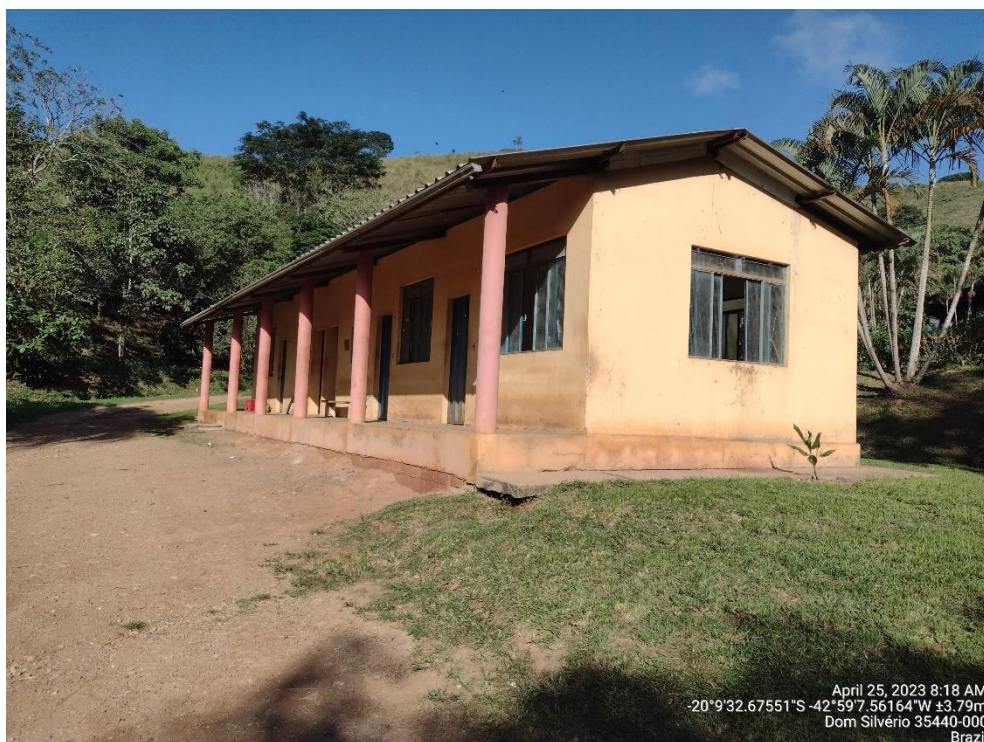
Figura 7. Vista da fachada principal e da lateral do prédio da administração.
