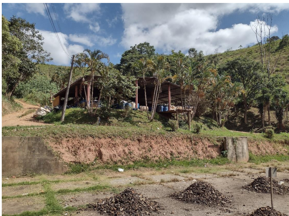
Figura 2. Vista da fachada principal do galpão de triagem e do pátio de degradação.
