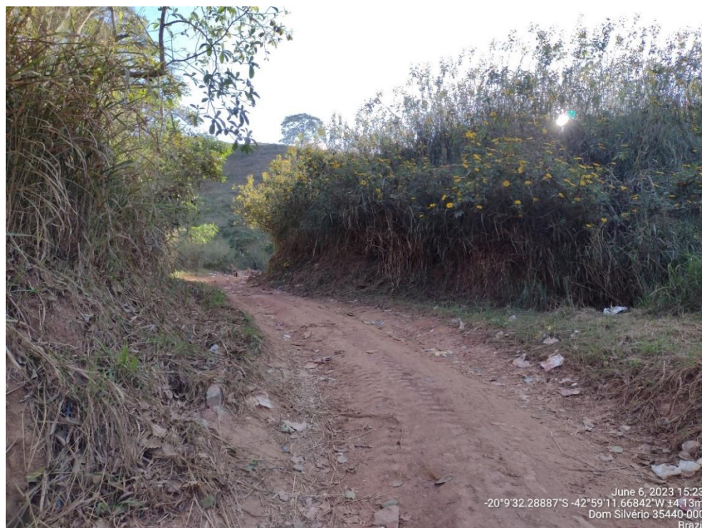
Figura 13. Vias no interior da Usina sem canaleta/sarjeta.
