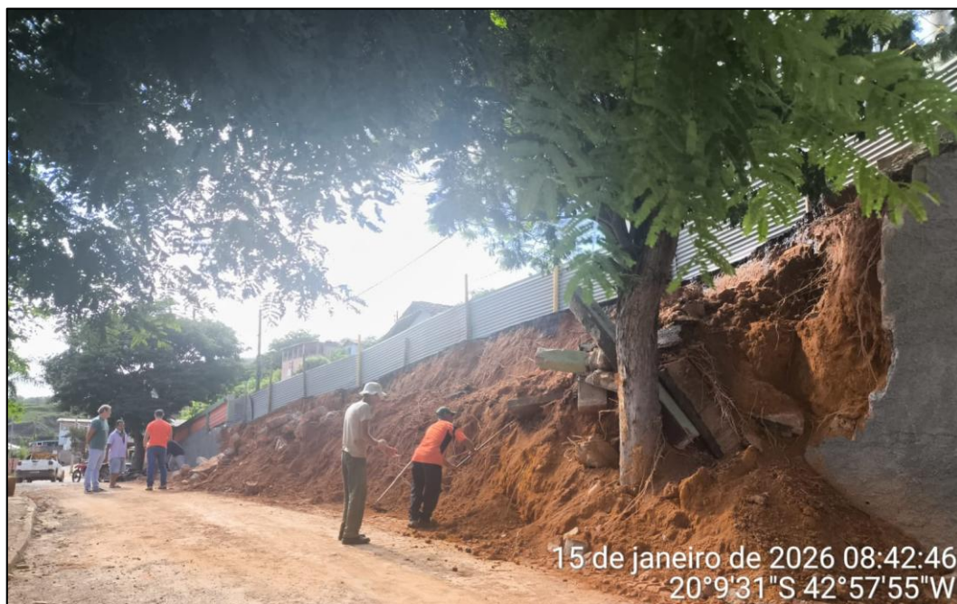
Foto 02- Local onde será construído o novo muro
