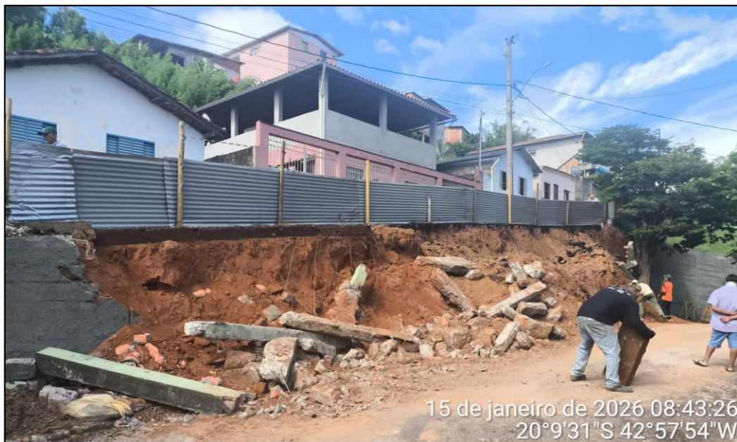
Foto 01- Local onde será construído o novo muro
